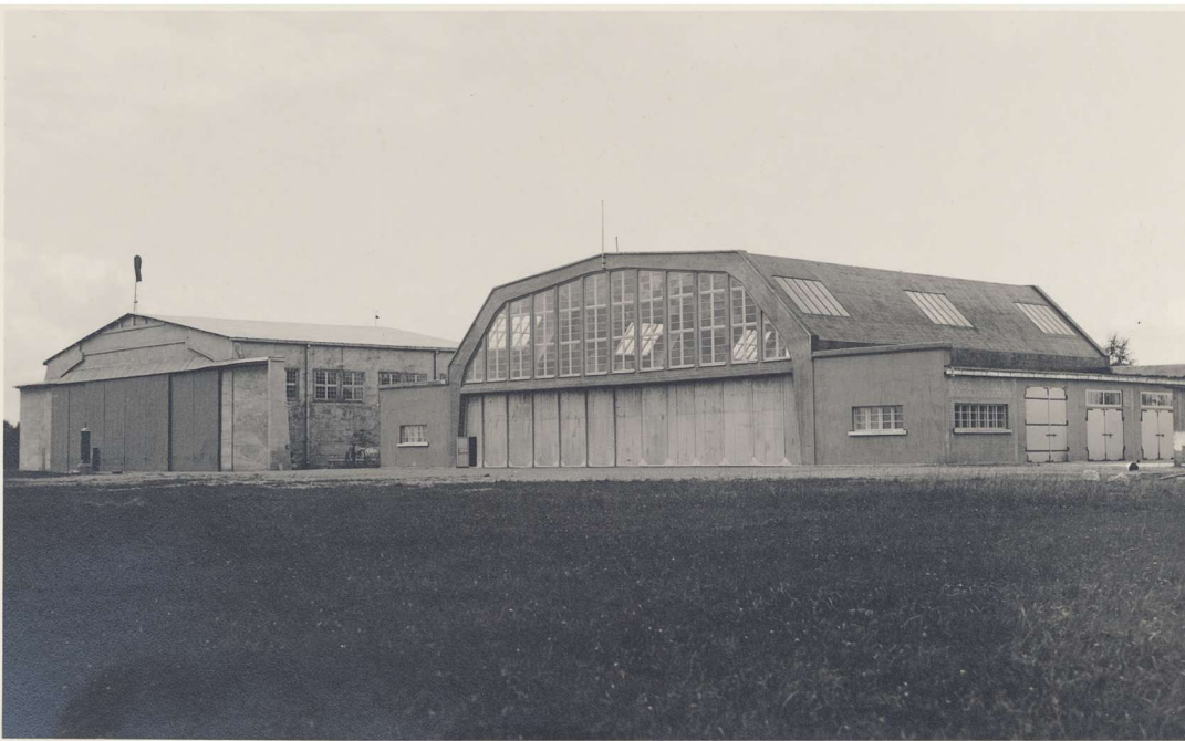
Komendandi esimene suurem tööobjekt oli Tartu Roosi tänava raudbetoonist moodsa vormiga lennuväeangaar (1936), teadaolevalt varaseim eelpingestatud terasega ehitus Eestis (1930. aastate foto).
