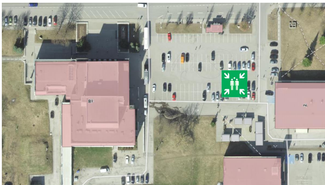
Foto. Hoone evakuatsioonijärgne kogunemiskoht
