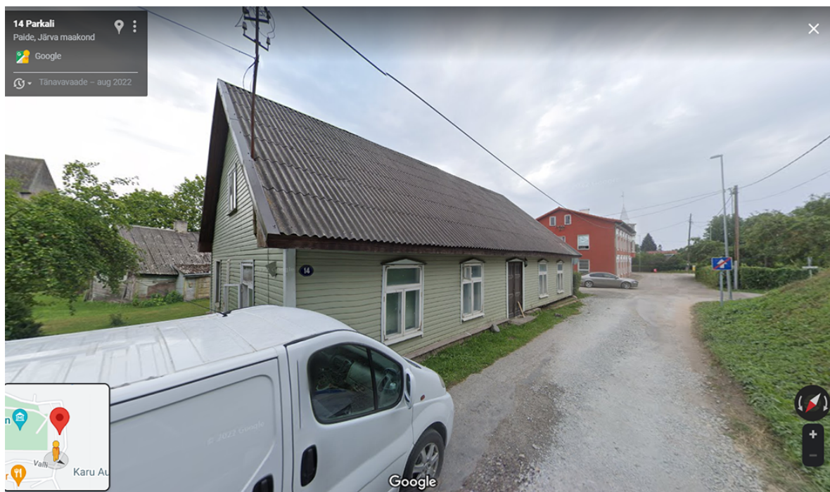
Foto 21. Vaade piki Parkali tänavat põhjast lõunasuunal. Vaade Parkali tn 14 ja Parkali 18 hoonetele. Google streetview 2022.
