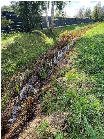
Foto 3 Jõeääre teekraavi on kogunenud vähesel määral setet
